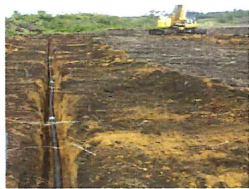
④パイプを布設完了時の様子
