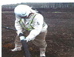
③パイプを接続している場面
